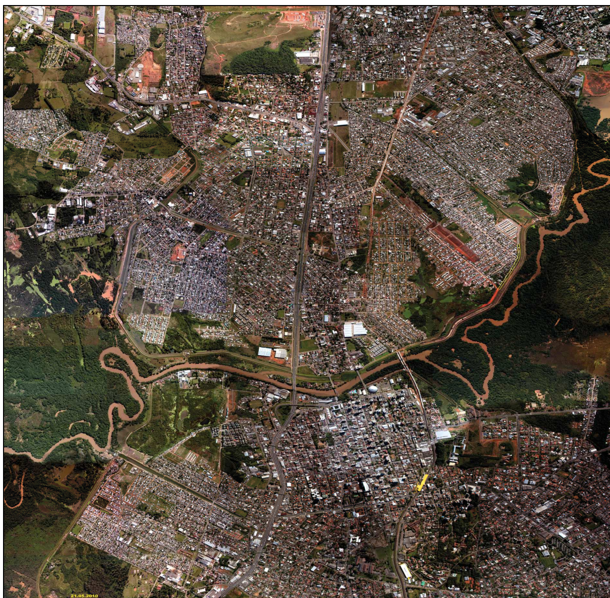
Figura II.59: Vista aérea do Sistema de Proteção Contras as Cheias (Diques). Fonte: SEMMAM, 2010.
