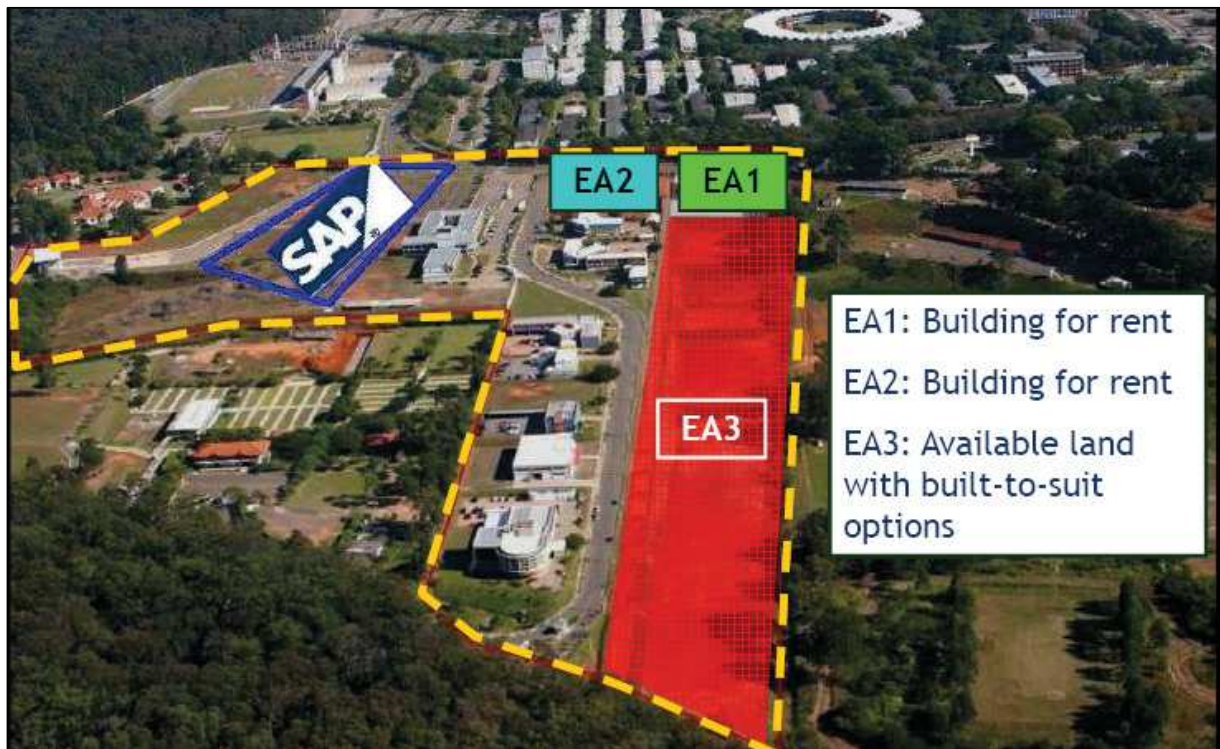
Figura II.111: Vista aérea do Parque Tecnológico. Legenda: EA1 – Prédio da Fase II, obras em conclusão, com espaços para alugar; EA2 – Prédio da Partec, concluído, empresas se instalando; EA3 – Área terraplenada para expansão da Fase II; SAP - Prédio da SAP, em obras. Fonte: SEMEDES, 2010.
