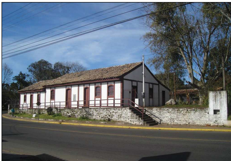
Figura II.73: Vista da Casa da Feitoria. Fonte: IPHAE, 2010.
