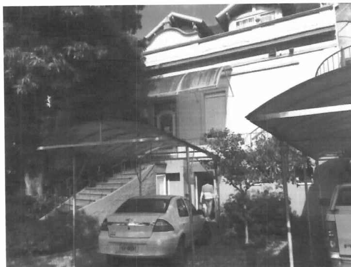
Imagem 1. Vista Fachada principal da casa
