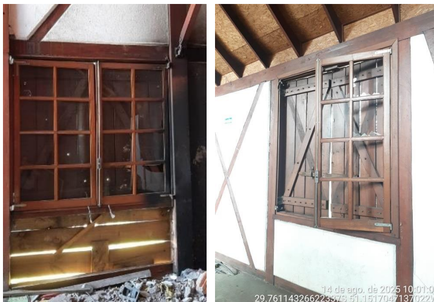
Figura 01 e 02: Janelas a serem removidas
