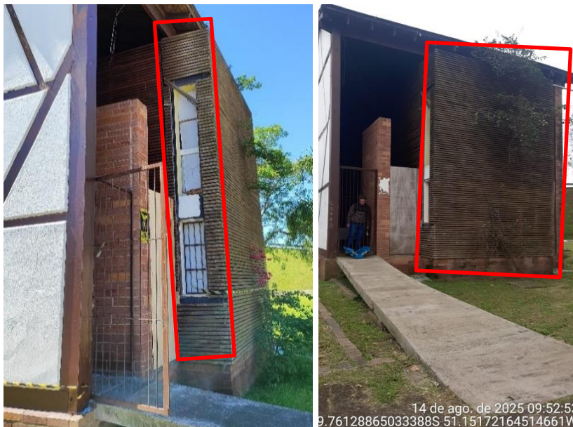
Figura 05 e 06: Painéis ripados a serem removidos
