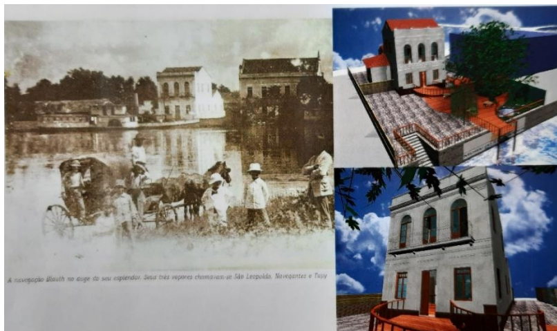
Figura 20 - Projeto de Revitalização da Rua da Margem - Museu do Rio dos Sinos (2007)
