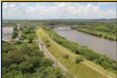
AEIA dos Diques
