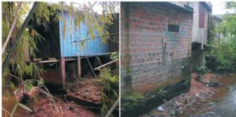
Moradias nas margens do arroio Cerquinha. Fonte: Projeto MONALISA, 2006.
