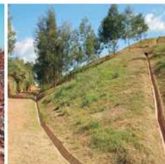
Célula já finalizada com sistema de drenagem superficial e fiores para queima das gases. Fonte: SEMMAM, 2010.
