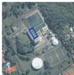
Ampliação de Elevatória de Água Tratada da ETA 001 - R1 e da ETA 001 - Morro do Espelho. Fonte: SEMAE.
