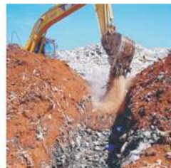
Abertura de voçorcas para canalização e drenagem das águas superficiais e das águas. Fonte: SEMMAM, 2010.
