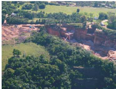
Pedreira irregular no Morro de Paula. Fonte: PMSL, 2010.
