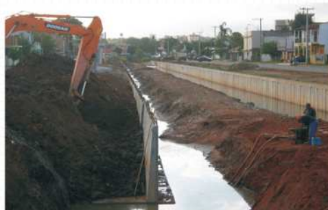
Construção da calha aberta. Fonte: SEMMAM, 2012.
