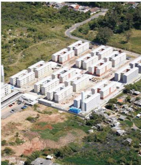
Residencial Creta e Residencial Malta, do Programa "Minha Casa Minha Vida" e Residencial Arubo. Fonte: PMSL 2011.
