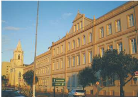
Antigo prédio da UNISINOS. Fonte: PNMIL.
