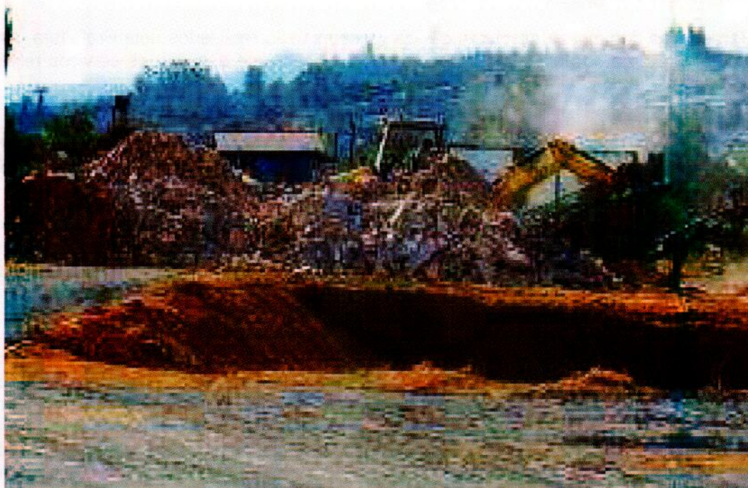
Figura 16 - Usina de reciclagem de RCC.
