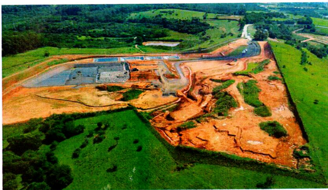
Figura 15 - Aterro Sanitário da CRVR – São Leopoldo/RS.
