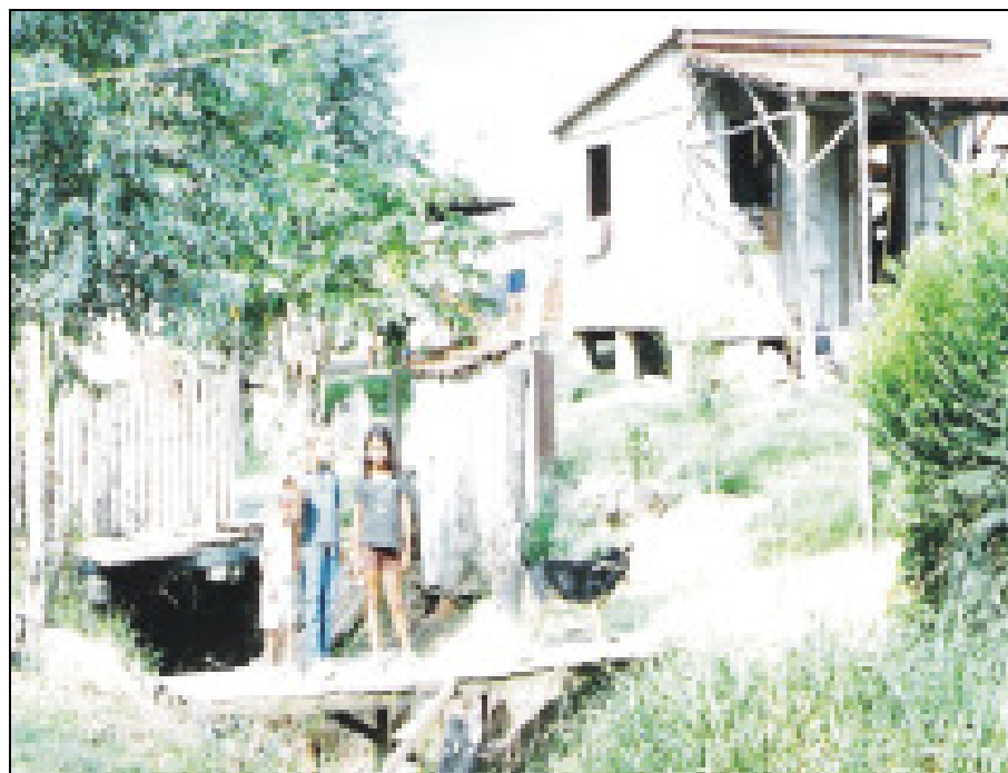
Figura III.76: Situação do esgoto aberto, causando erosão e riscos de desabamento das casas, resquício de mata ciliar resistindo às agressões humanas e Pontes e banheiros sobre o Arroio da Manteiga, região Coopervale. Fonte: SEMMAM, 2010.
