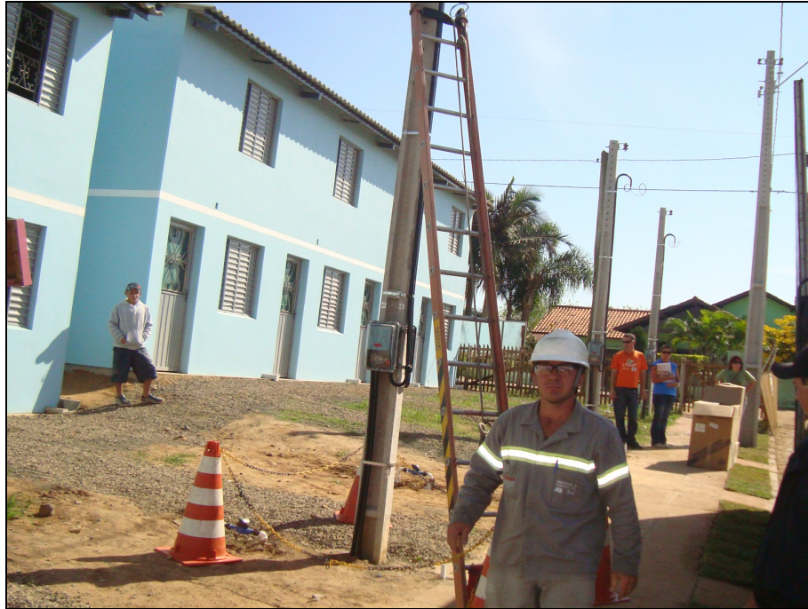
Figura III.28: Instalação da rede elétrica. Fonte: PAC/Kruze, 2010.
