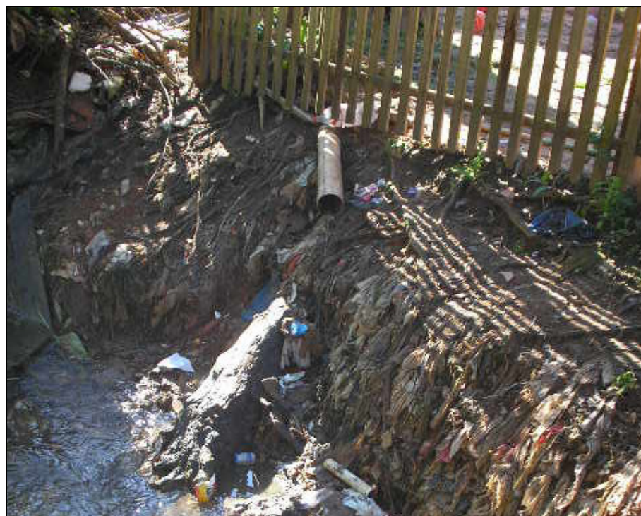
Figura III.74: Efluentes líquidos liberados no Arroio da Manteiga. Falta de saneamento básico compromete a saúde dos moradores. Fonte: SEPLAN/PAC.
