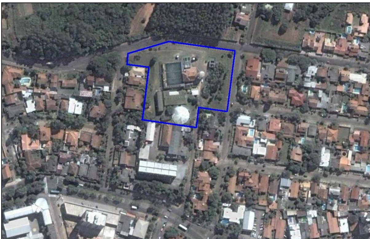
Figura III.24: Ampliação Elevatórias ETA 01 - Contrato CEF 0228.795-27/07 PAC – FGTS. Fonte: SEMAE, 2010.
