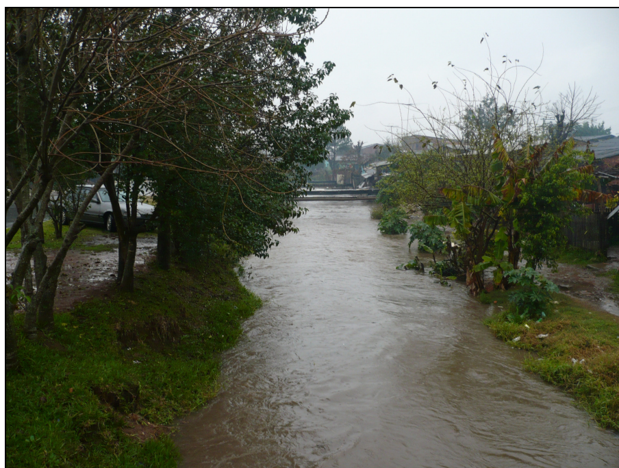
Figura III.53: Calha do arroio Gauchinho em época de cheia. Fonte: SEMMAM, 2010.
