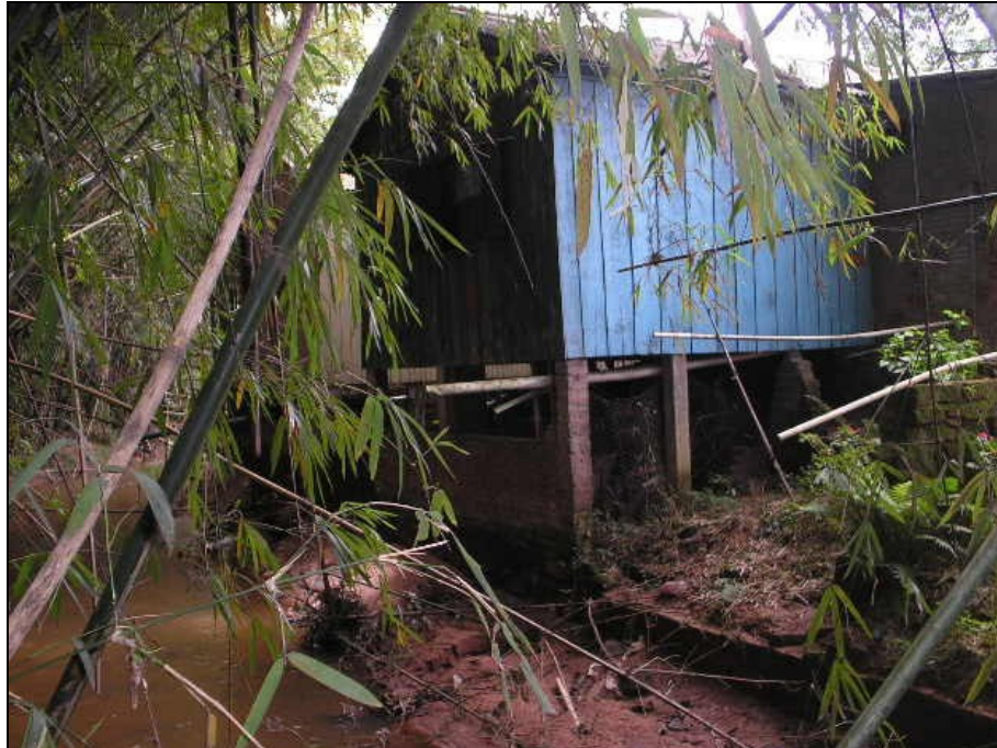
Figura III.64: Moradia nas margens do Arroio Cerquinha. Fonte: Projeto MONALISA 2005.
