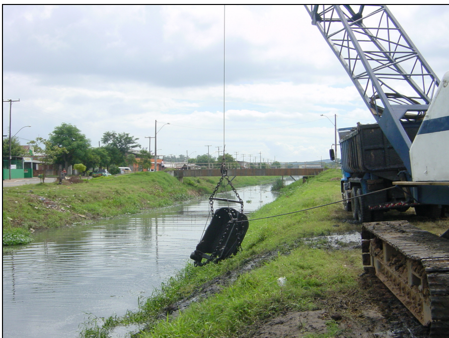
Figura III.96: Limpeza na calha aberta do arroio João Correa. Fonte: SEMMAM, 2010.
