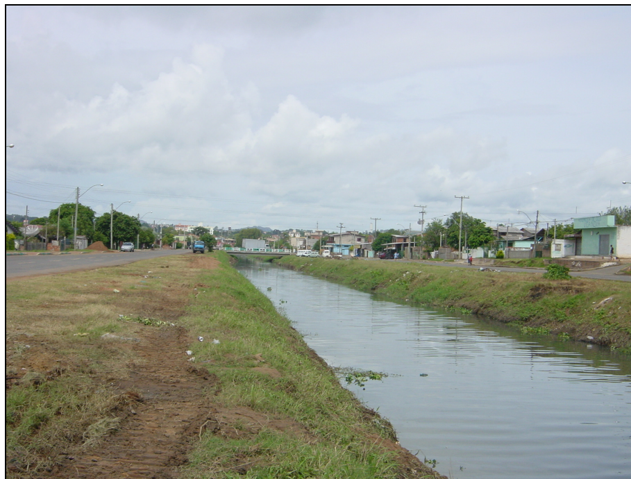
Figura III.95: Calha aberta do arroio João Correa. Fonte: SEMAM, 2010.
